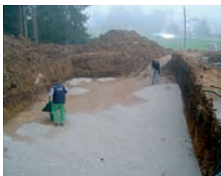
Iskopavanje pred postavljanje zemnih kolektora
