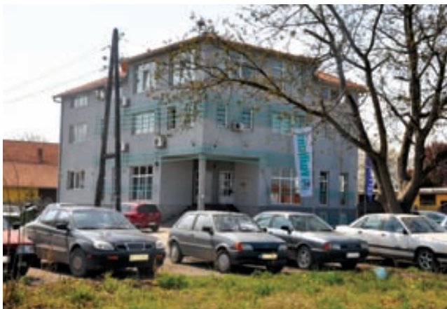
Reprezentativna poslovna zgrada Energy Neta u Kaću
