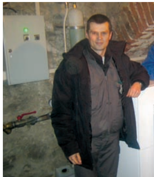
Za instalaterske radove u Izbenici je bila zadužena firma Ami monter, naravno uz pomoć g. Tasića iz Predstavništva
