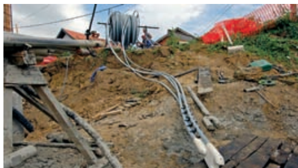
Toplotna pumpa u objektu Amadeo se napaja preko dubinske sonde
