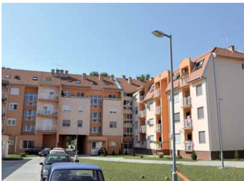
Reprezentativni objekat u centru Bačke Palanke, BIR je izveo sve radove i ugradio opremu Vaillanta
