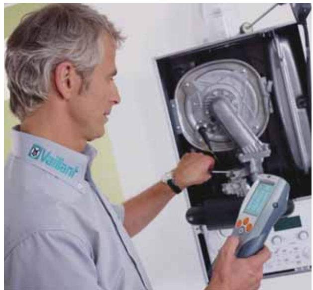
Analizator dimnih gasova spada u neophodnu opremu za puštanje u rad kondenzacionih kotlova
