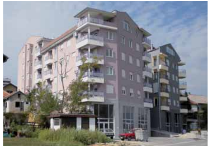
Stambena zgrada u G.Milanovcu opremljena sa 34 kotla VUW 242
