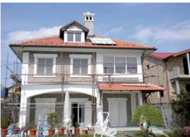
Porodična kuća sa Vaillant kolektorima
