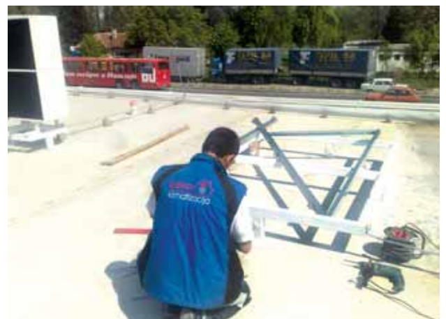
Montaža solara u toku
