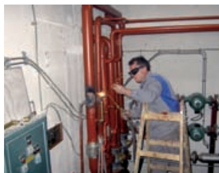
Tvrtka je osposobljena za obavljanje vrlo složenih i zahtjevnih instalaterskih poslova
