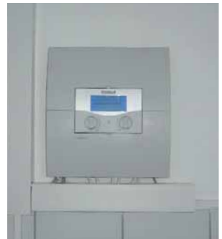
vrnetDIALOG ima 24-satni „on-line“ nadzor nad radom kotlovnice
