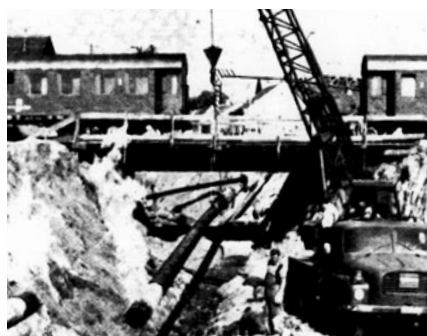
Rekonstrukcija visokotlačnog plinovoda 1980.g., radovi pod pothodnikom
