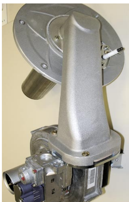
Termokompaktni modul plinske armature s područjem modulacije od 30 do 100 posto
