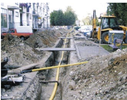
Rekonstrukcija dotrajale plinske mreže
