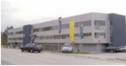
Poslovna zgrada u Ljubljani u kojoj je ugrađen atmoCRAFT VKM 3004/9
