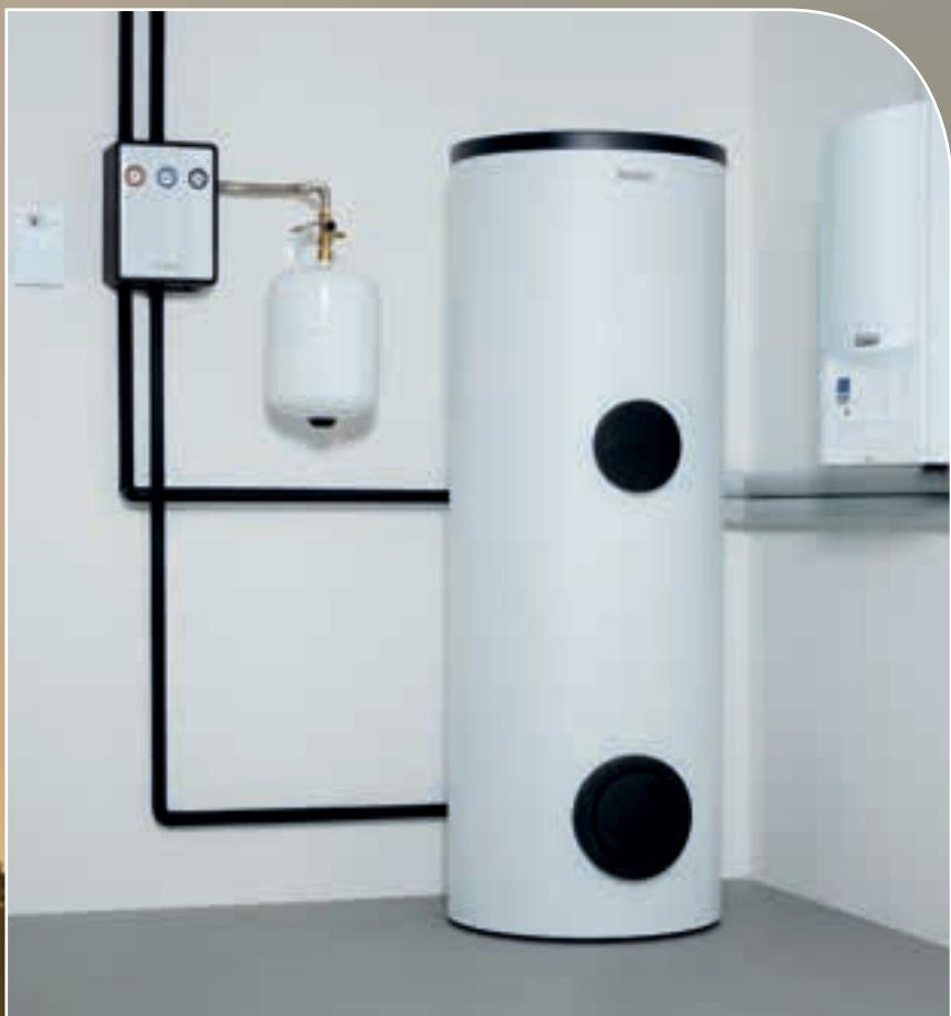
Solarni sistem za pripremu PTV s ecoTEC, auroSTOR, VMS 70 i VRS 570
