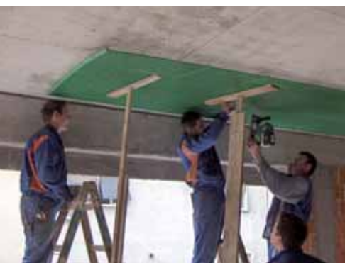
Ugradnja climasystema u žbukani strop
