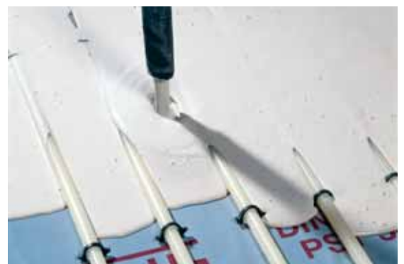
Samonivelirajući tekući estrih FE50Largo i FE25Largo idealan su materijal za podno grijanje
