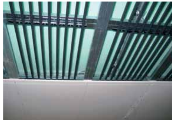
Montaža ploča Knauf Thermoboard plus na strop
