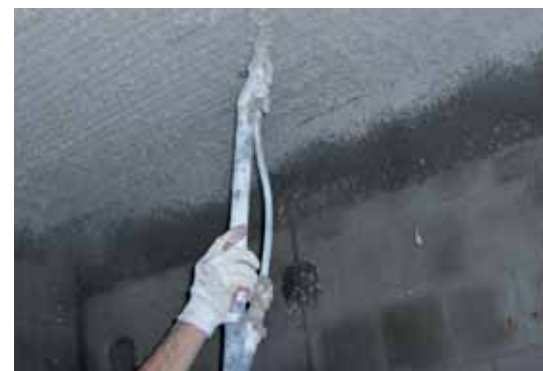
Žbukanje stropnih climasystem registara
