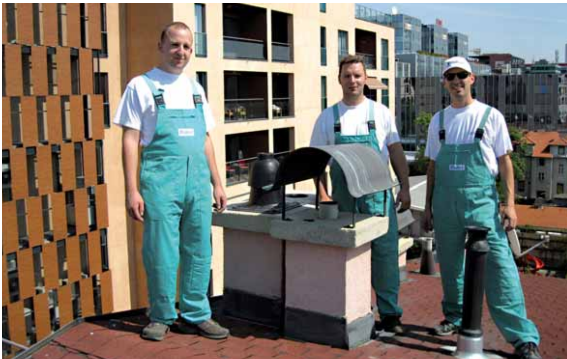
Ekipa Instalatera nakon završene sanacije dimnjaka
