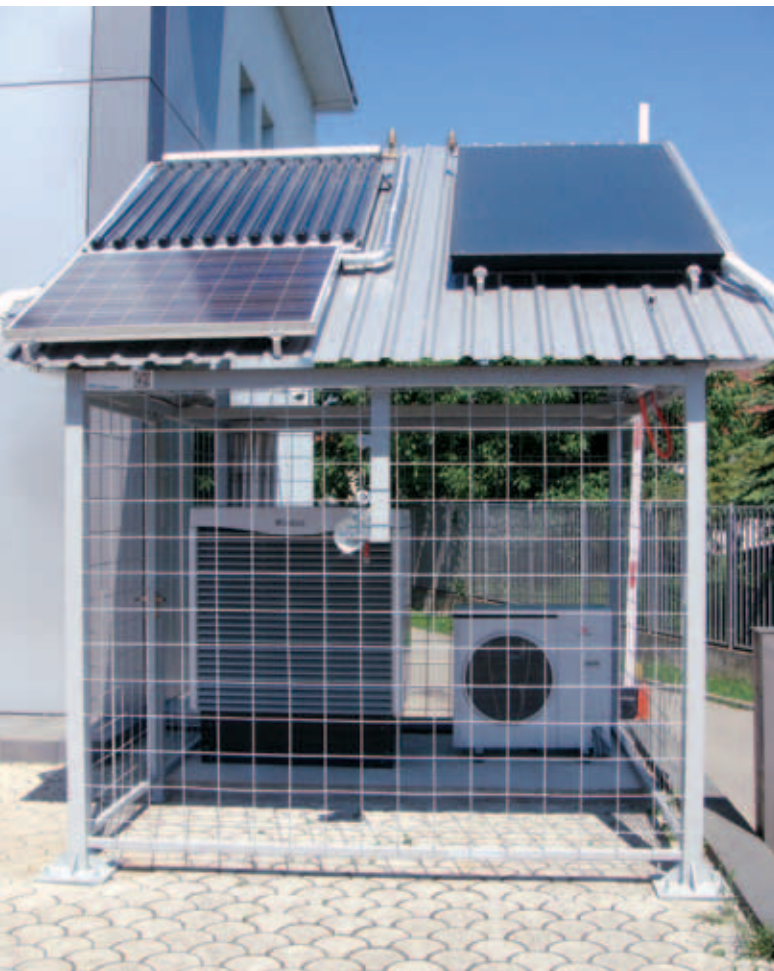
Solarni kolektori auroTHERM, fotonaponski kolektor auroPOWER i vanjske jedinice dizalica topline geoTHERM VWL S i Genia Air 8.
