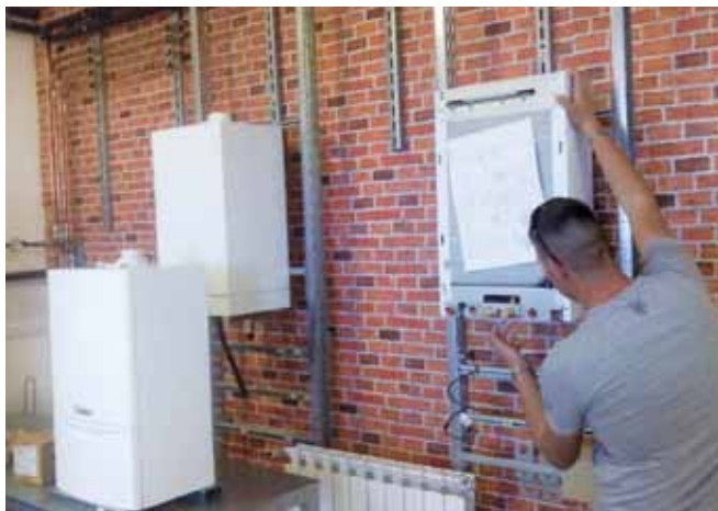
Učenik za vrijeme instalacije spremnika
