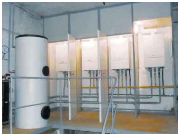
Imunološki zavod - 4 ecoTEC VU 466, spremnik VIH R 300, VRC 630/3
