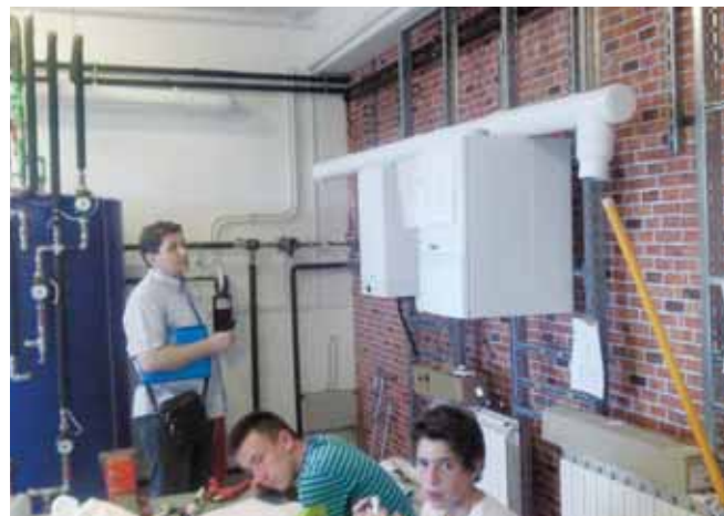
Spremnik i kondenzacijski uređaj nakon instalacije
