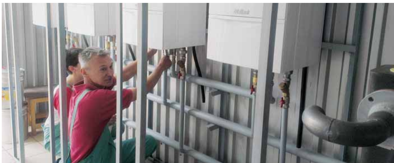
Montiranje uređaja 4 ecoTEC u Naftalini
