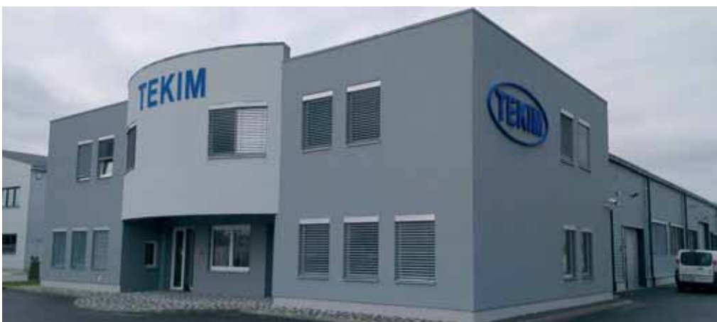
Tekim opremljen s 2 kondenzacije VU 466 i 5 klima VAI1
